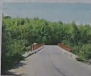
GORE EJECUTÓ OBRA.
